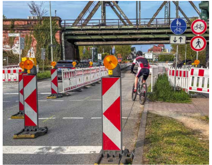
Sichere Führung des Radverkehrs an einer Baustelle: In Niederrad wurde dazu eine Kfz-Fahrspur umgewidmet
