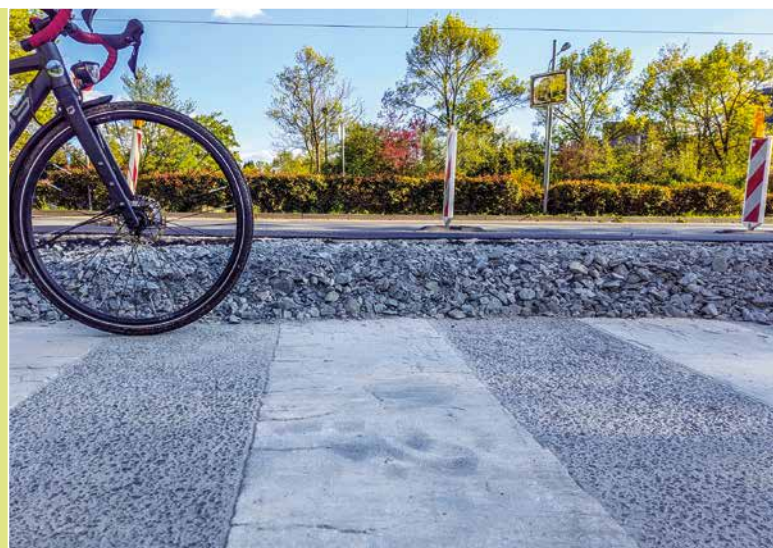
Der Höhenunterschied zwischen dem alten, niedrigen Übergang und dem neuen, erhöhten Radweg (auf dem Schotterbett dahinter) ist beachtlich. Zukünftig bleibt Radfahrenden dieses Auf und Ab (und die Fahrt über holprige Bordsteinkanten) erspart.
